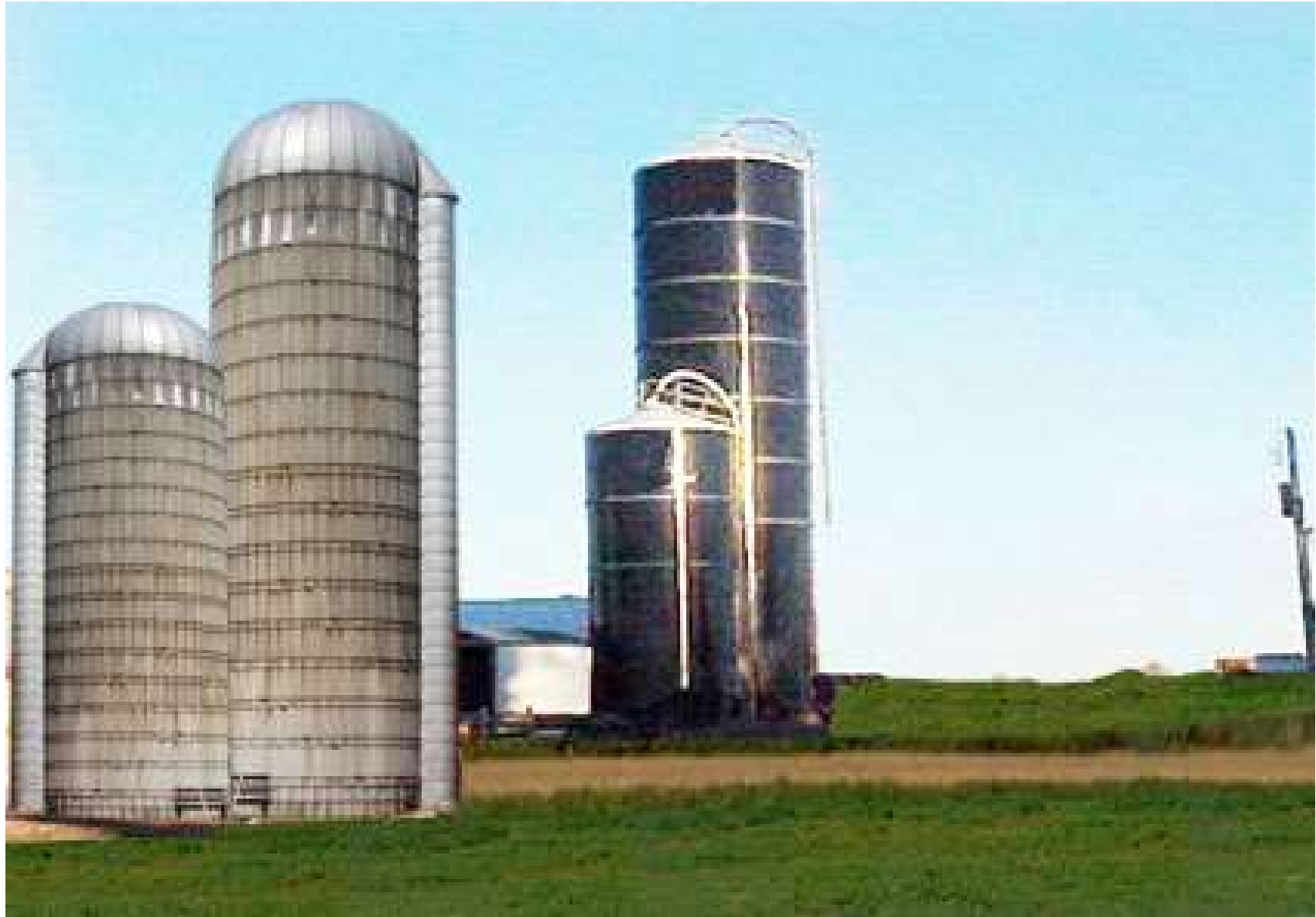
سیلوه‌های برجی بتونی و فلزی
